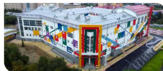
ЦЕНТР СОЦИАЛЬНОГО ОБСЛУЖИВАНИЯ НАСЕЛЕНИЯ «ДОВЕРИЕ» В САЛЕХАРДЕ Введён в эксплуатацию в 2024 г.
