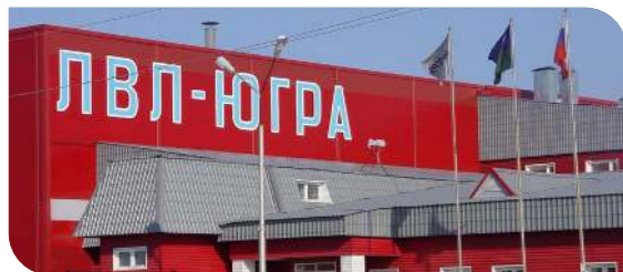
ЗАВОД ПО ПРОИЗВОДСТВУ КЛЕЕНОГО БРУСА «ЛВЛ-ЮГРА» В ХАНТЫ-МАНСИЙСКОМ АВТОНОМНОМ ОКРУГЕ Введён в эксплуатацию в 2003 г.
