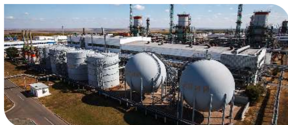
ГЕЛИЕВЫЙ ЗАВОД «ГАЗПРОМ ДОБЫЧА ОРЕНБУРГ» (ВОССТАНОВЛЕНИЕ ПОСЛЕ ТЕХНОЛОГИЧЕСКОЙ АВАРИИ) Введён в эксплуатацию в 2009 г.
