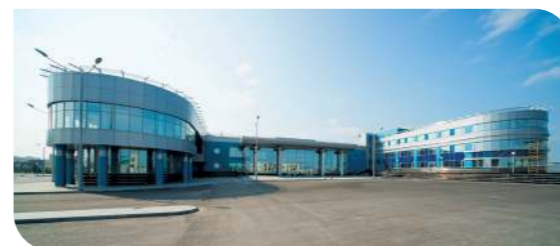
МНОГОФУНКЦИОНАЛЬНЫЙ ВОКЗАЛ В НОВОМ УРЕНГОЕ Введён в эксплуатацию в 2015 г.
